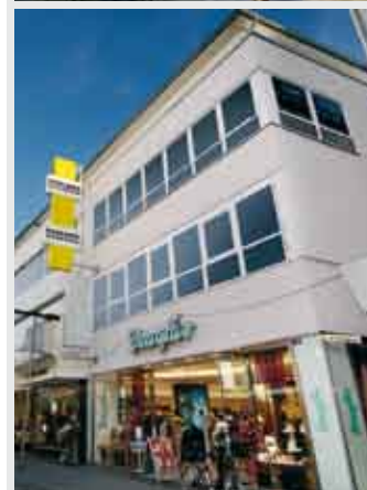
Geschäftshaus Krefeld, Hochstraße 123-131
